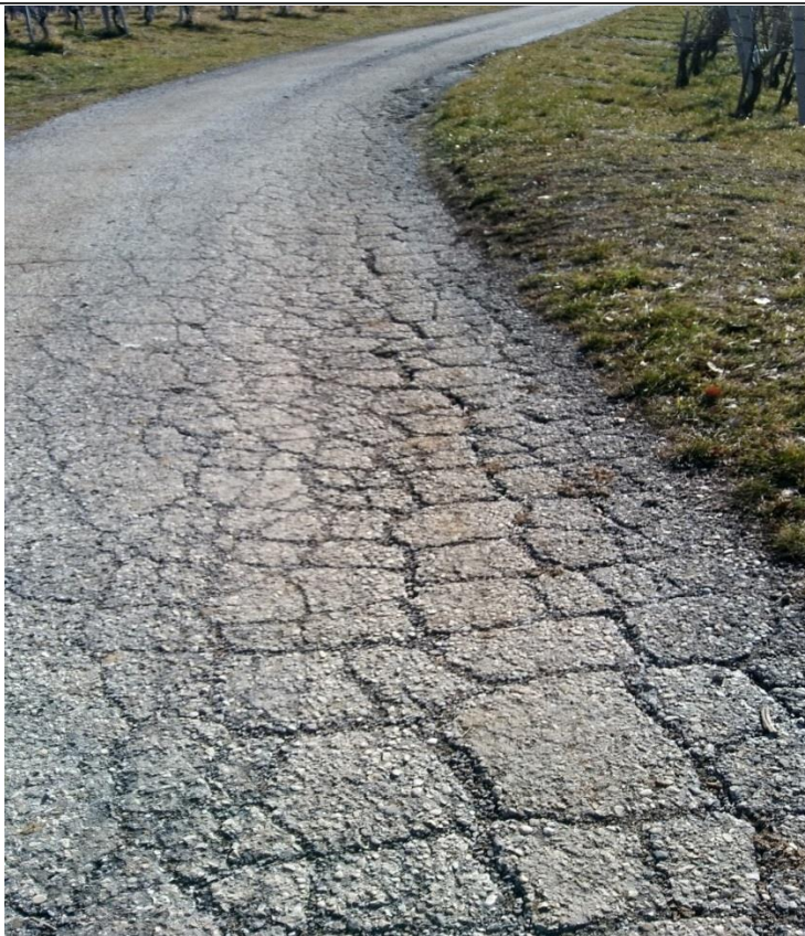
Slika 3: Značilne poškodbe vozišča - mrežaste razpoke in posedeni robovi vozišča
