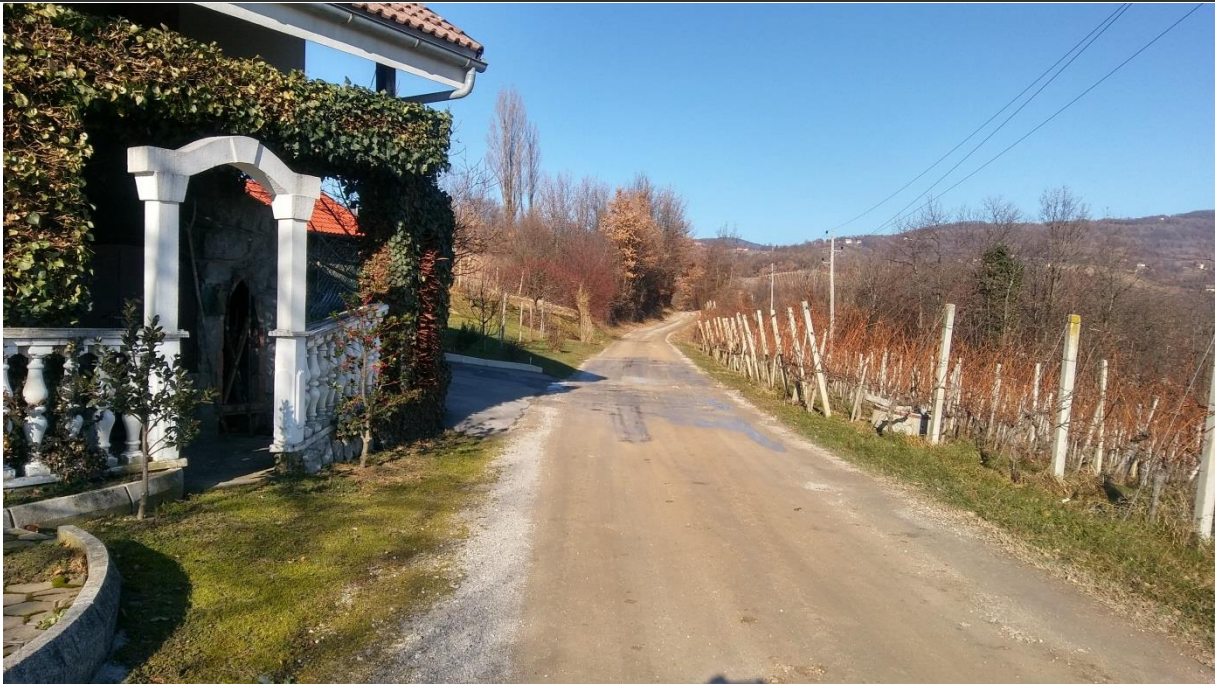
Slika 7: Zastajanje površinske vode na delu makadamskega vozišča
