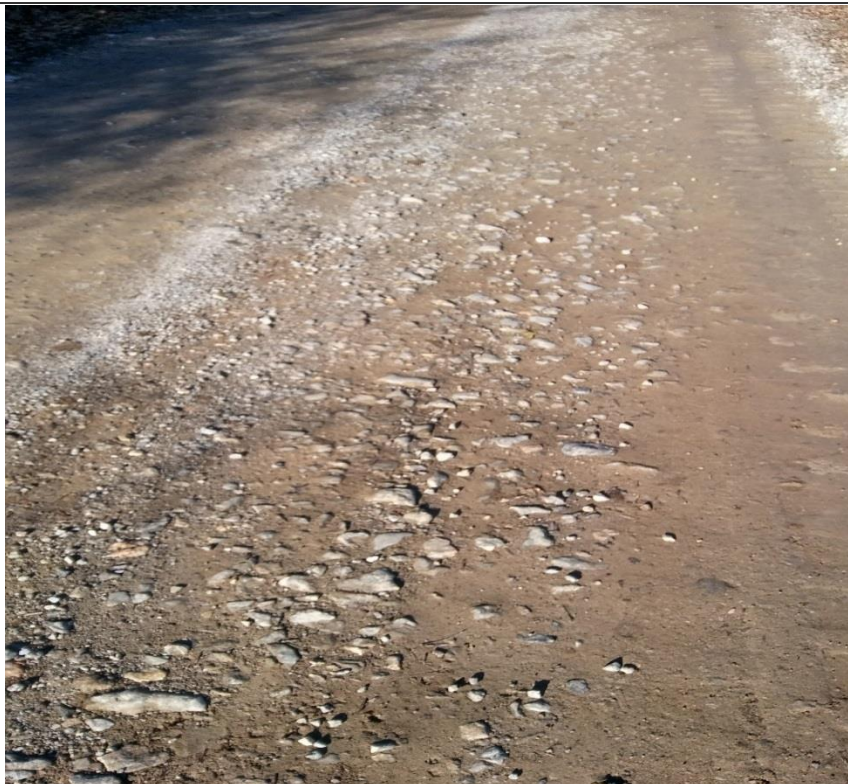
Slika 5: Stanje obstoječega makadamskega vozišča (pojav kolesnic)
