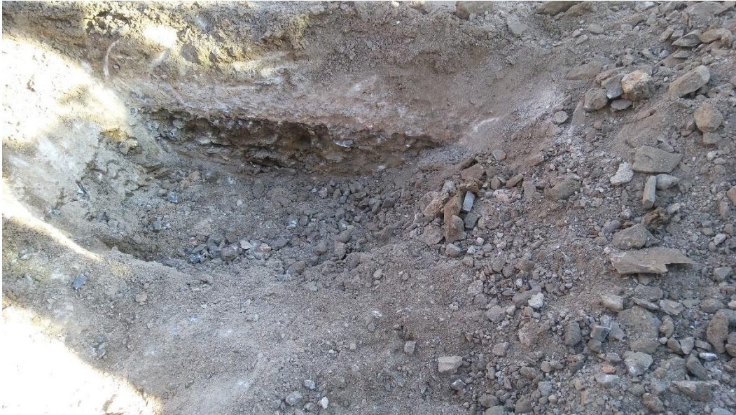
Slika 9: Sondažni razkop (obstoječa voziščna konstrukcija)
