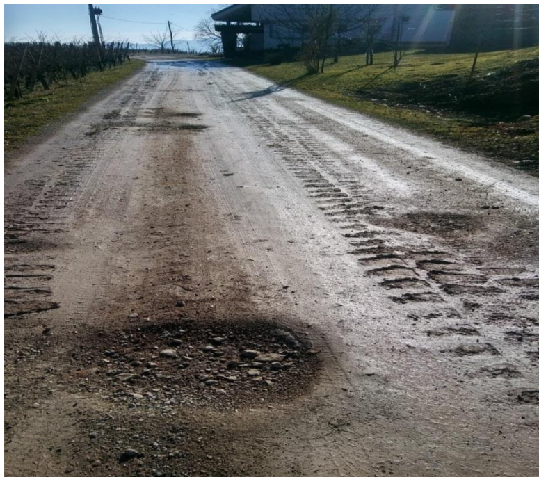
Slika 2: Značilne poškodbe vozišča - udarne jame na makadamskem vozišču (na začetku obravnavanega odseka pri Vinarstvu Mavretič)
