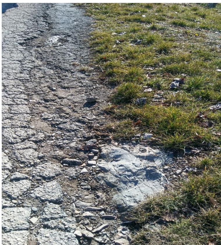
Slika 4: Značilne poškodbe vozišča - krušenje robov asfaltnih plasti
