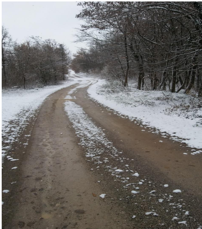
Slika 8: Pojav kolesnic in zastajanje vode na makadamskem delu vozišča
